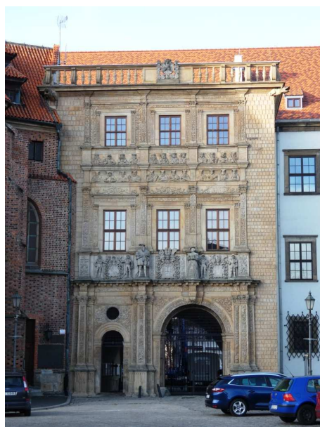
Fot. 5 Skrzydło południowe. Portal główny budynku bramnego. Elewacja E11
