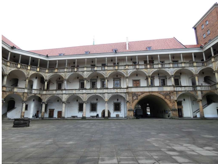
Fot. 5 Krużganki skrzydła południowego , elewacja E12
