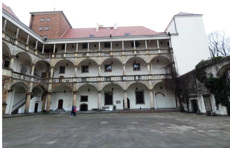
Fot. 7 Krużganki skrzydła zachodniego , elewacja 23
