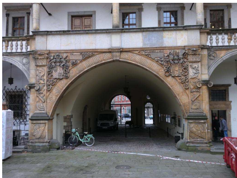
Fot. 6 Portal bramy głównej od strony dziedzińca , elewacja 12
