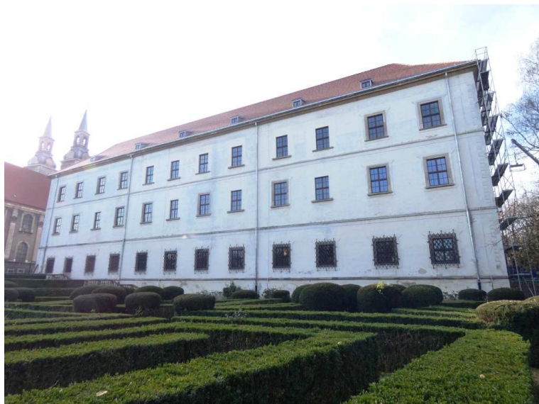
Fot. 1 Skrzydło wschodnie. Elewacja E5
