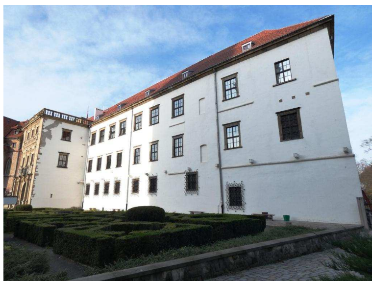
Fot. 4 Skrzydło południowe. Elewacje E9 i E10
