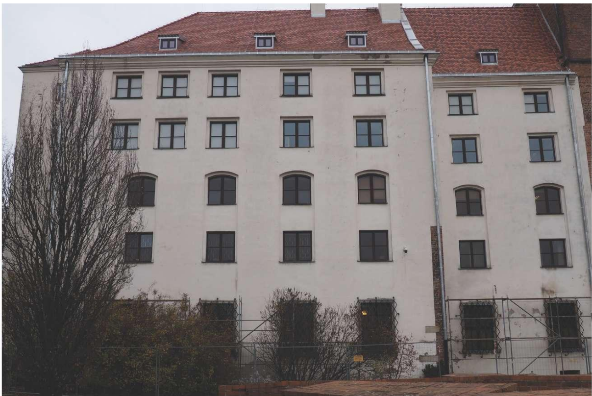
Kamieniarka elewacji skrzydła zachodniego E 19 i E 21
