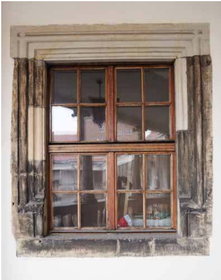
O.O.11.1 obramienie okna II p. skrzydła wschodniego inventaryzacja elemen- tów oryginalnych i rekon- strukcji
