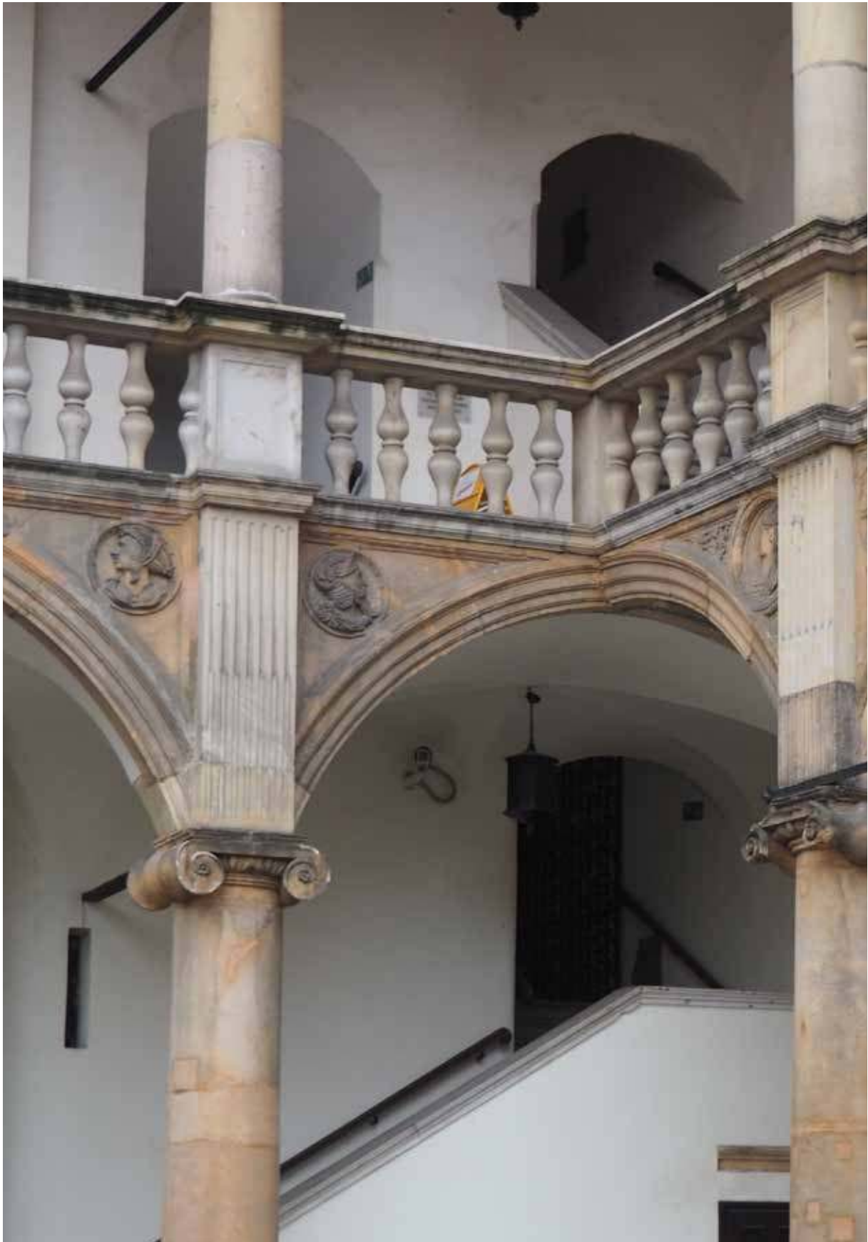
Oryginalna kamieniarka renesanasowa na parterze w narożniku skrzydła południowego i zachodniego
