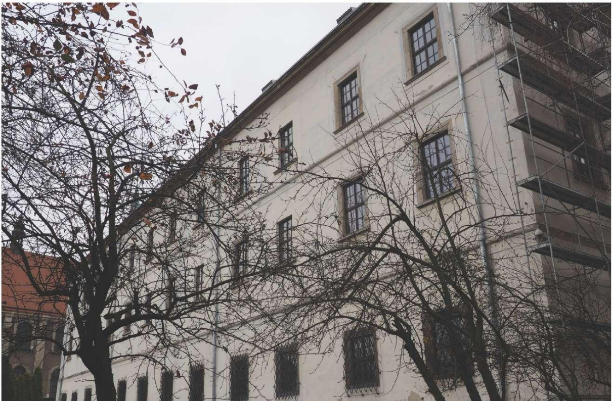
Kamieniarka elewacji skrzydła wschodniego E 5.
