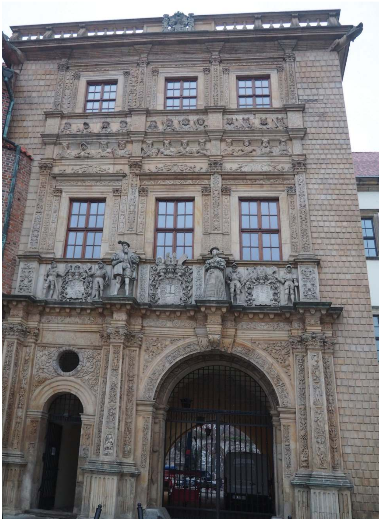
Wystrój kamieniarski elewacji frontowej bramy głównej zamku - widok ogólny.
