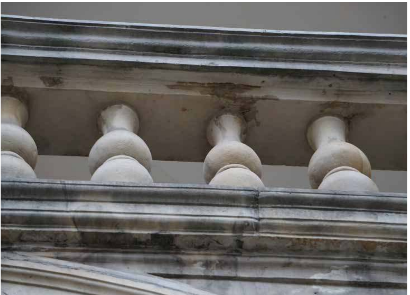
Widok ogólny krużganków I i II piętra. Poniżej fragment krużganków I i II piętra - zaplamienia w wyniku przeciekania wody opadowej przez elementy poziome balustrady.
