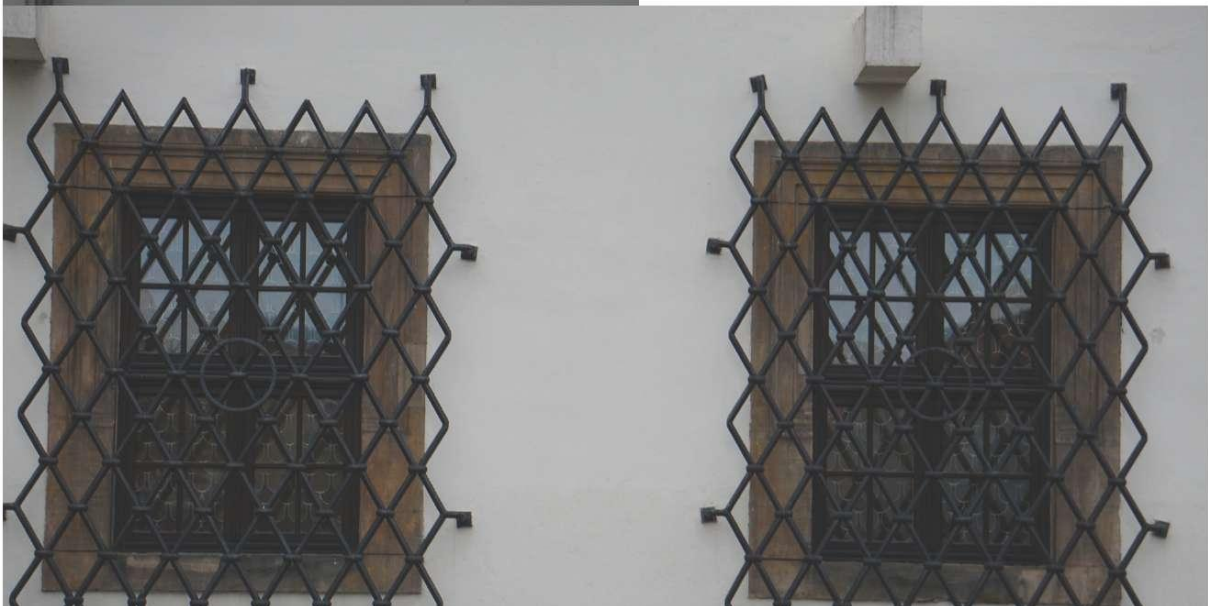
Przykłady oryginalnej kamieniarki skrzydła południowego E 11.
