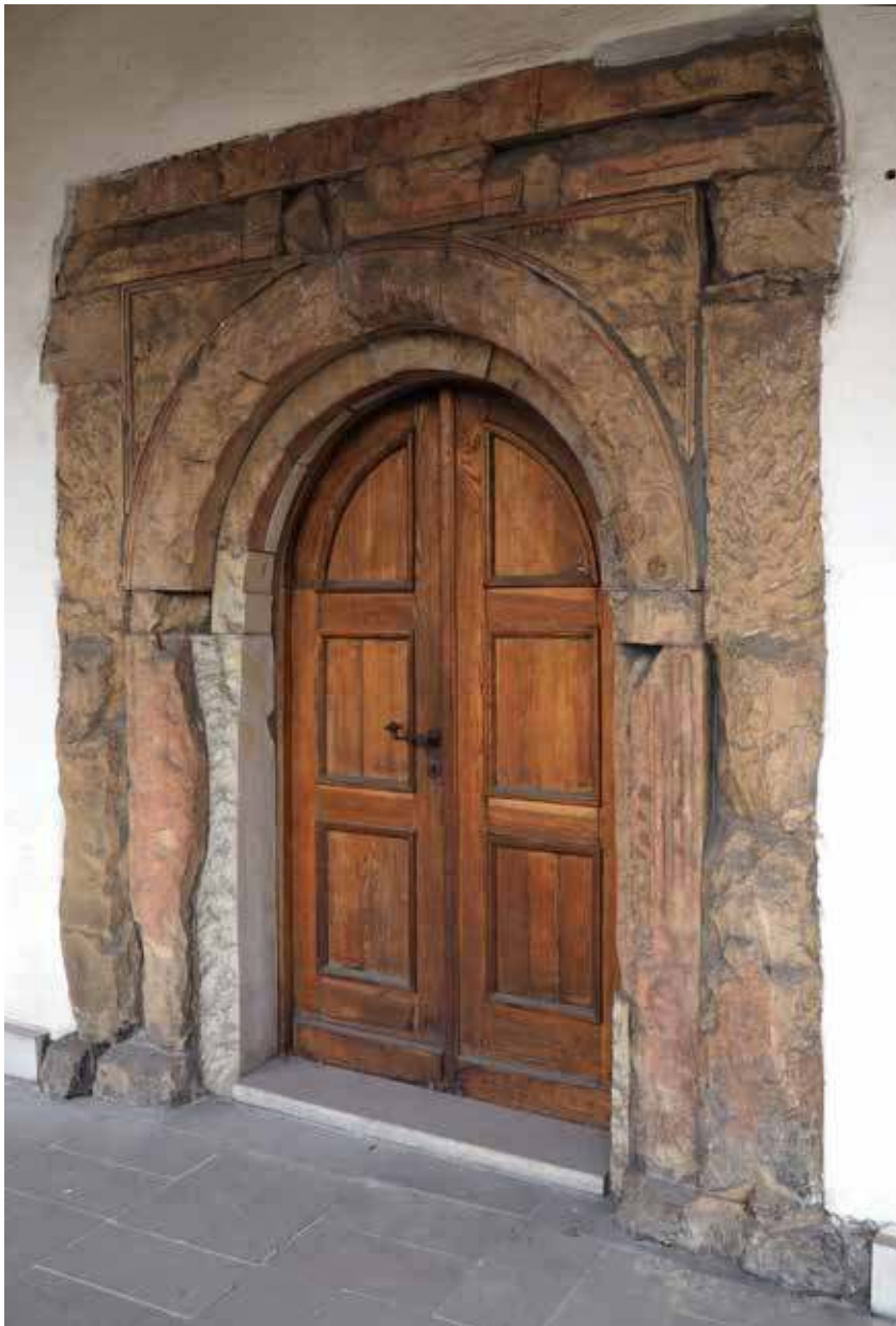
P.D.5, portal II piętra parteru skrzydła południowego, zachowa- ny w formie reliktywnej.
