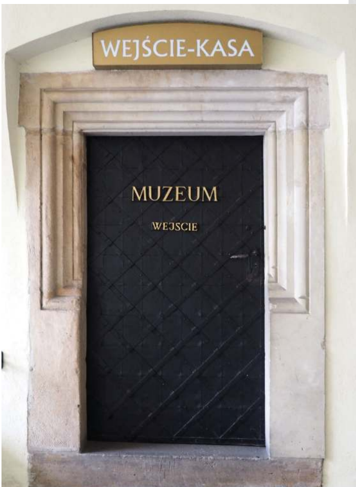
Elementy historycznej kamieniarki zlokalizowane w sieni. O.D.6, O.D.7, O.D.8
