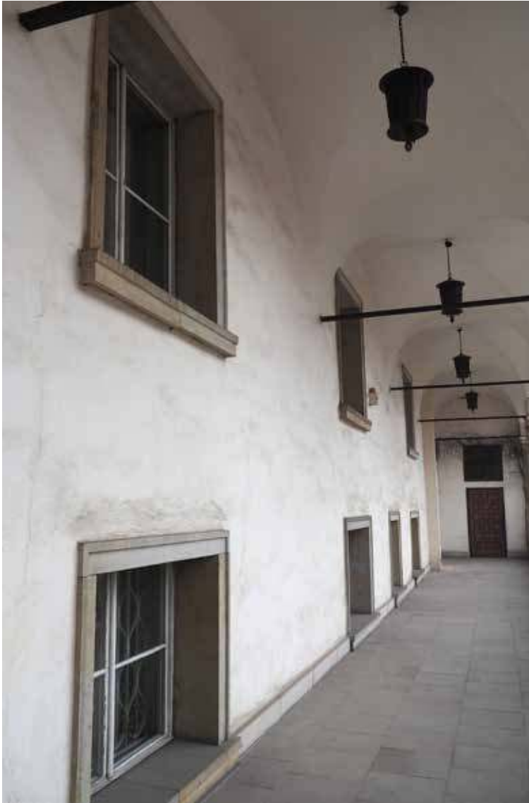
widok ogólny krużganków na II piętrze skrzydła zachodniego
