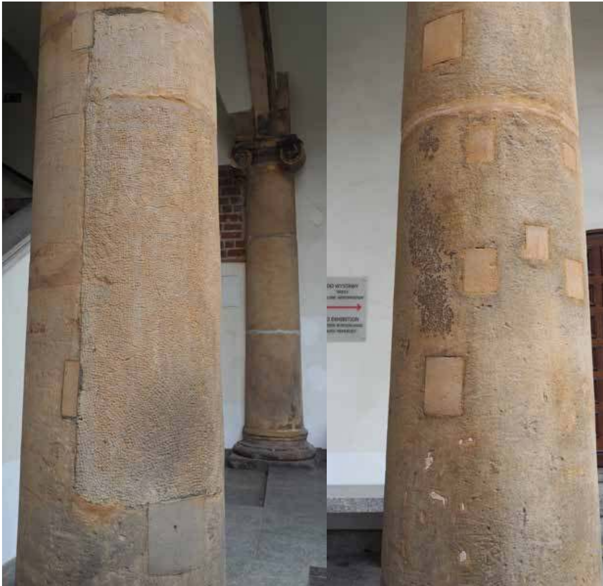
Nieodbrane naprawy kamieniarskie rozbijające optycznie trzony oryginalnych kolumn oraz uszkodzenia i korozja biologiczna baz kolumn i nakryw balustrad.
