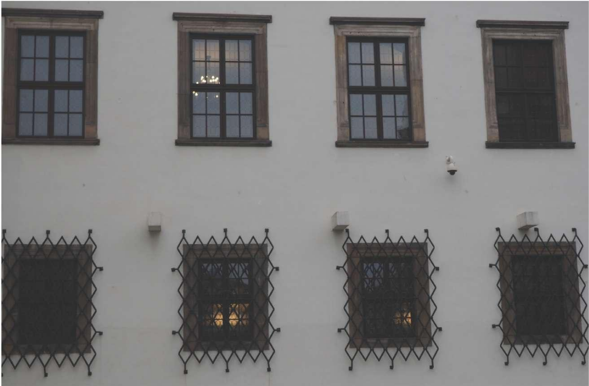
Kamieniarka fragmentu elewacji skrzydła południowego E 11.
