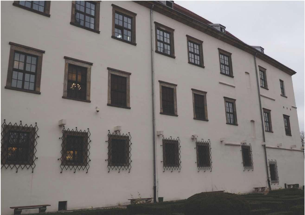
Kamieniarka elewacji skrzydła południowego E 11.
