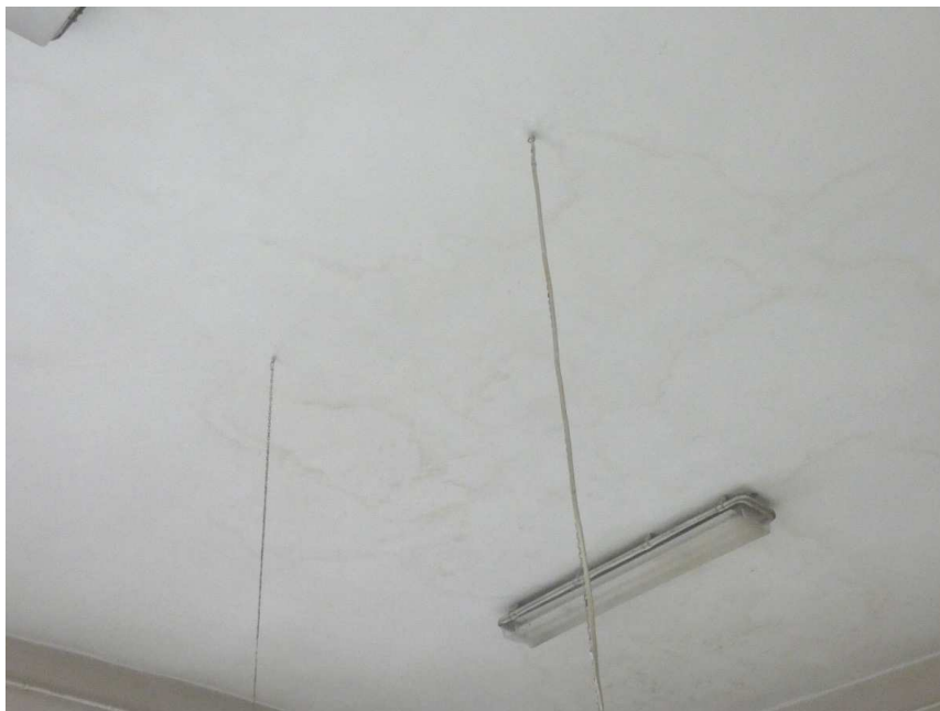
Fot. 3 - Widok fragmentu sufitu. Widoczne zacieki na suficie.
