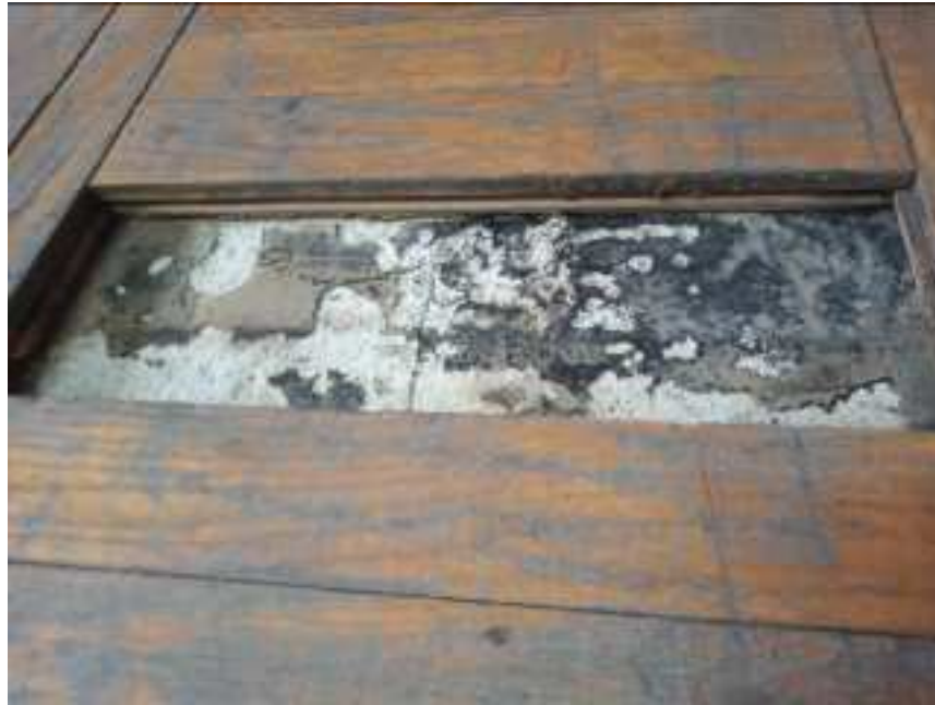
Fot. 2 - Widok fragmentu posadzki w miejscu oderwanej klepki. Podłoże z warstwą lepiku .
