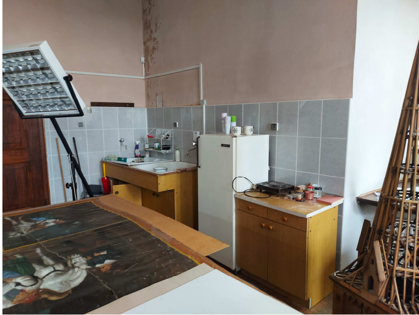
Fot. 4 - Widok okładziny ściennej zlewu.
